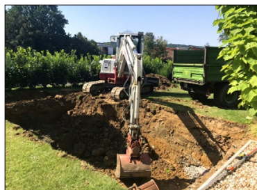
Step 1 Grube ausheben
